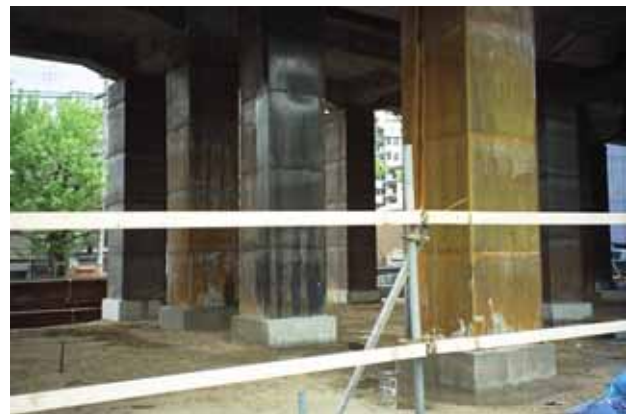
図 - 2 RC 構造物耐震補強
