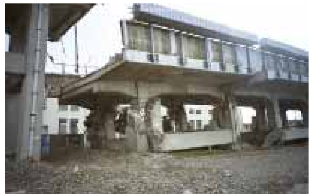
図 - 1 RC 構造物震災
